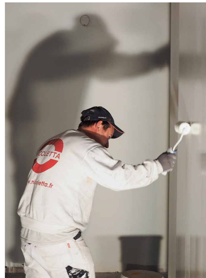
Travaux de peinture à l'intérieur du bâtiment— novembre/décembre 2022
